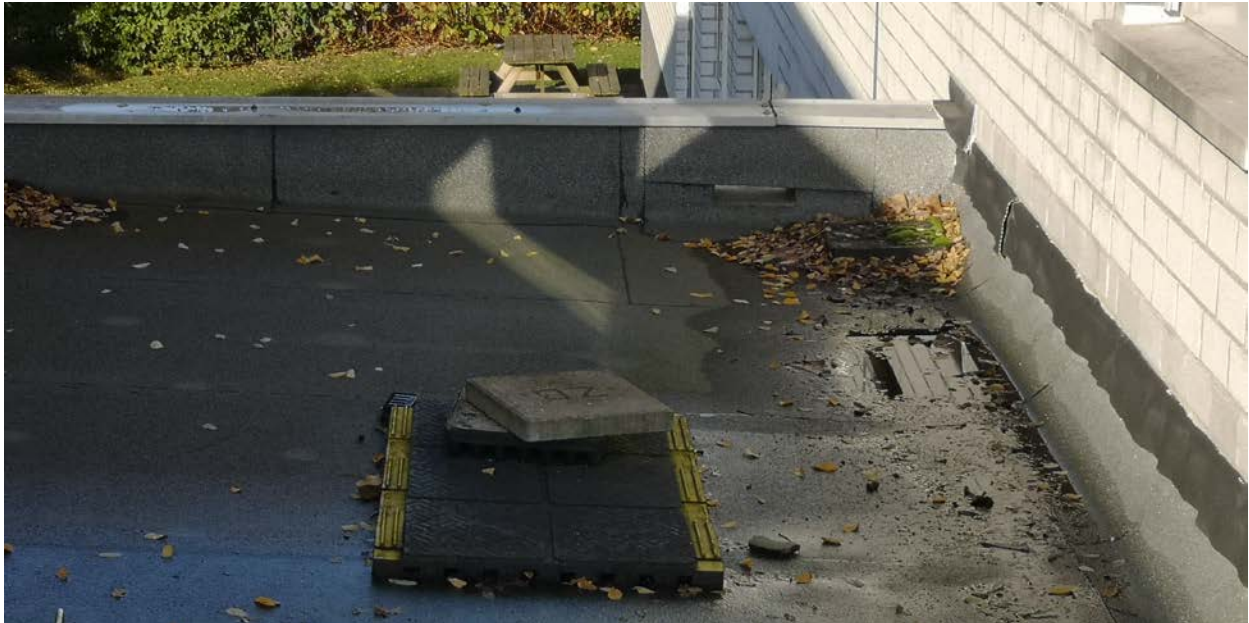
Figuur 11 | Spuwer is erg hoog ingeplakt op een plek waar een groot deel van het dak naartoe afwatert.
