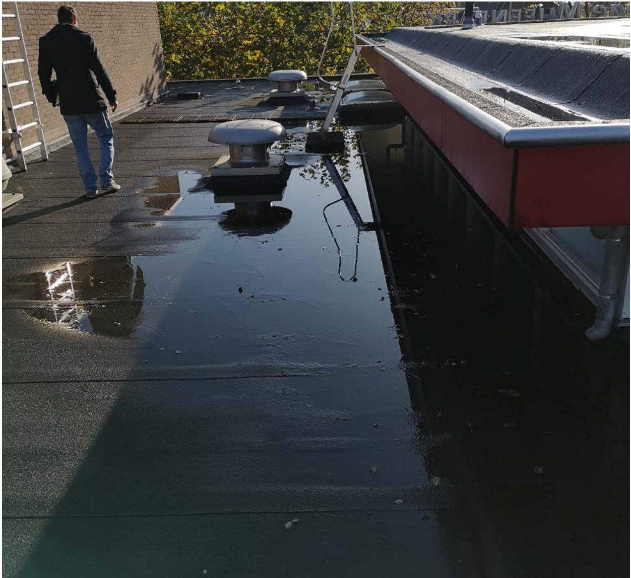
Figuur 12 | Op het platte dak rondom de entree veel plasvorming, geen noodoverlaten aanwezig.
