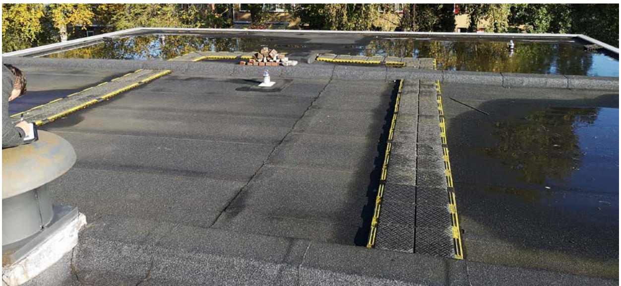
Figuur 10 | Op de gymzaal relatief veel plasvorming, slappe constructie en zachte isolatie onder de dakbedekking.
